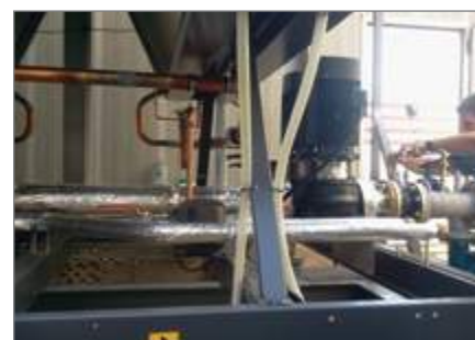
Hotel Capri: Trabajos durante la instalación
